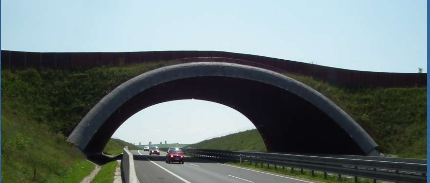
Obr. 12. Objekt 231 – most na D1 Mengusovce - Jánovce
