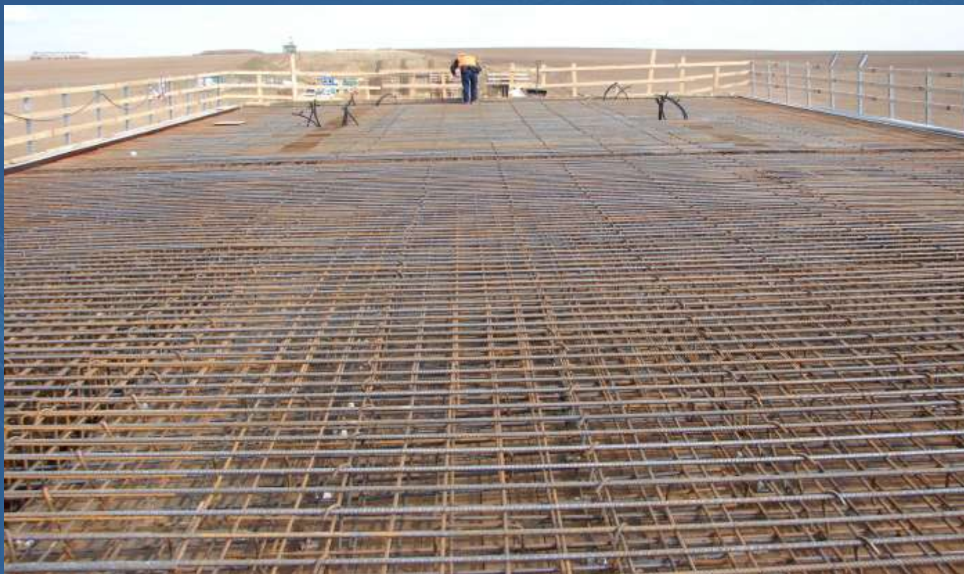
Obr. 15. výstuž pred betonážou
