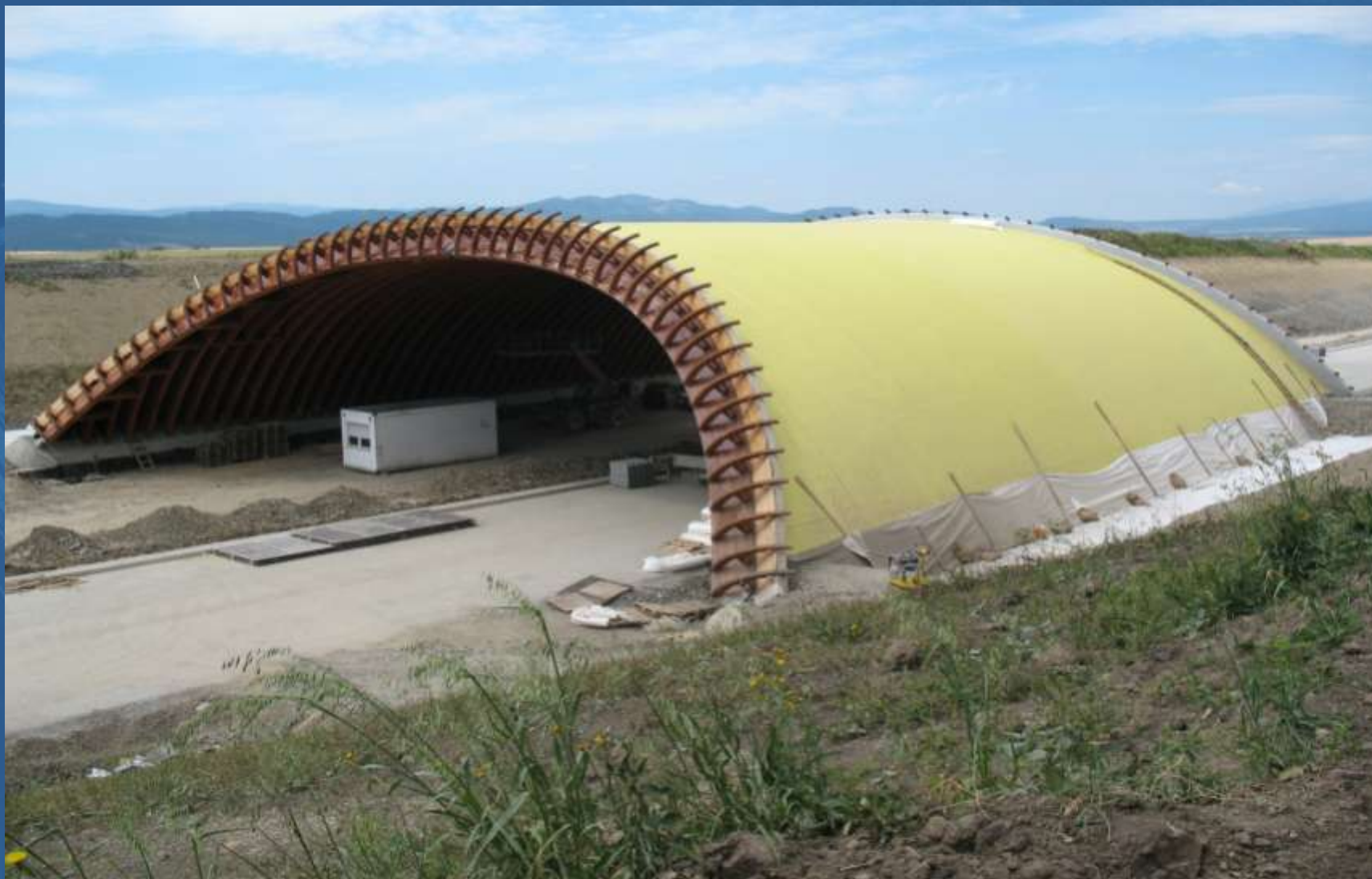
Obr. 11. Objekt 231 – most na D1 Mengusovce - Jánovce
