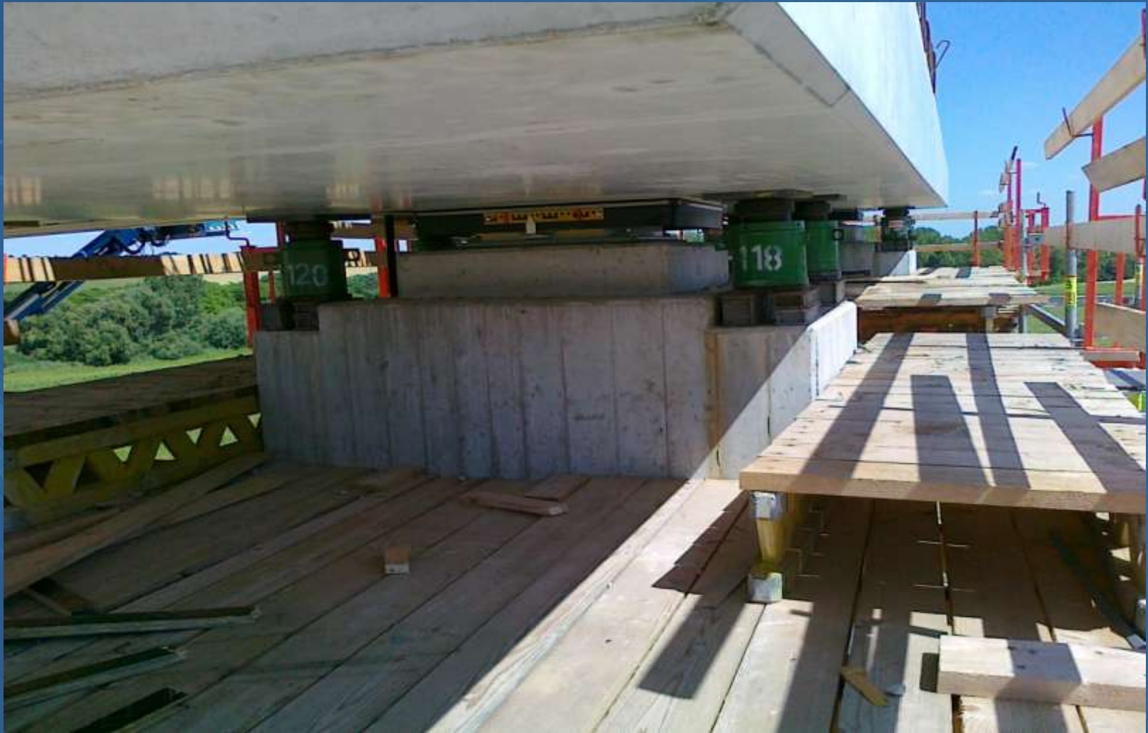
Obr. 8. Objekt 204– PPP R1 Selenec - Beladice
