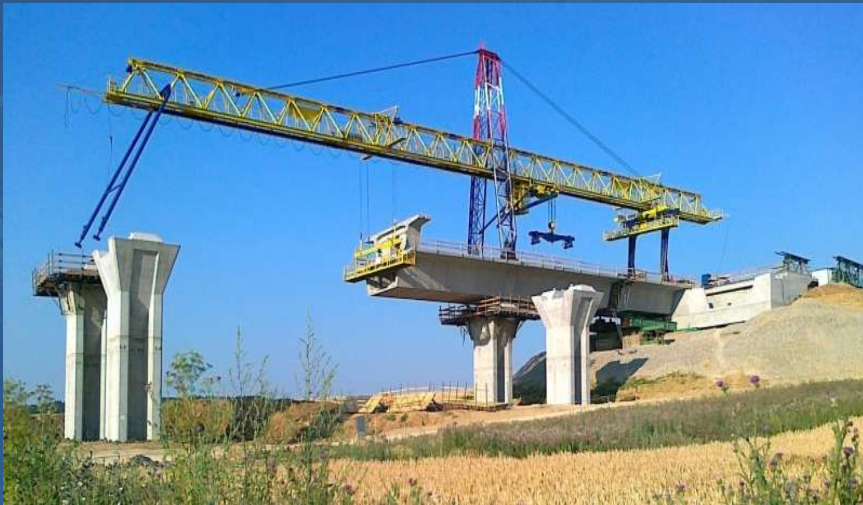
Obr. 9. Objekt 203 – most na R1PPP II. úsek Selenec - Beladice
