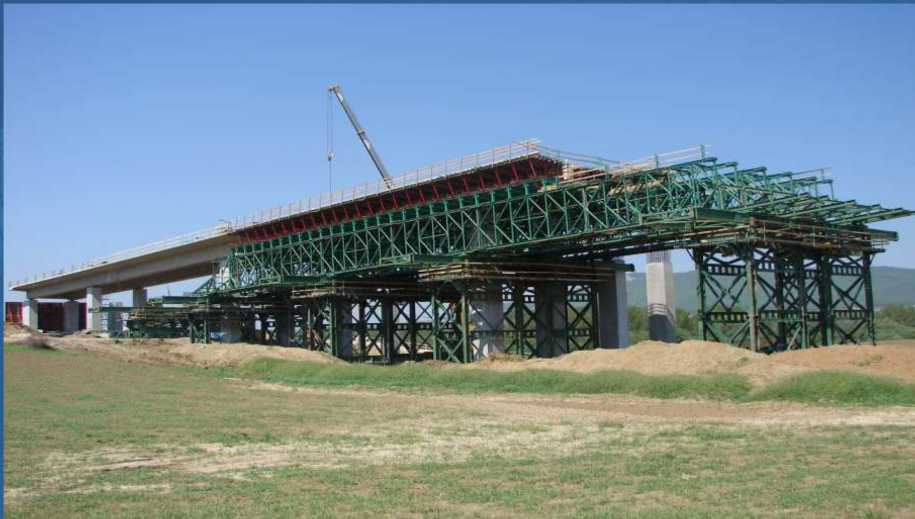
Obr. 4. Objekt 202 – most na R1 PPP II. úsek Selenec - Beladice
