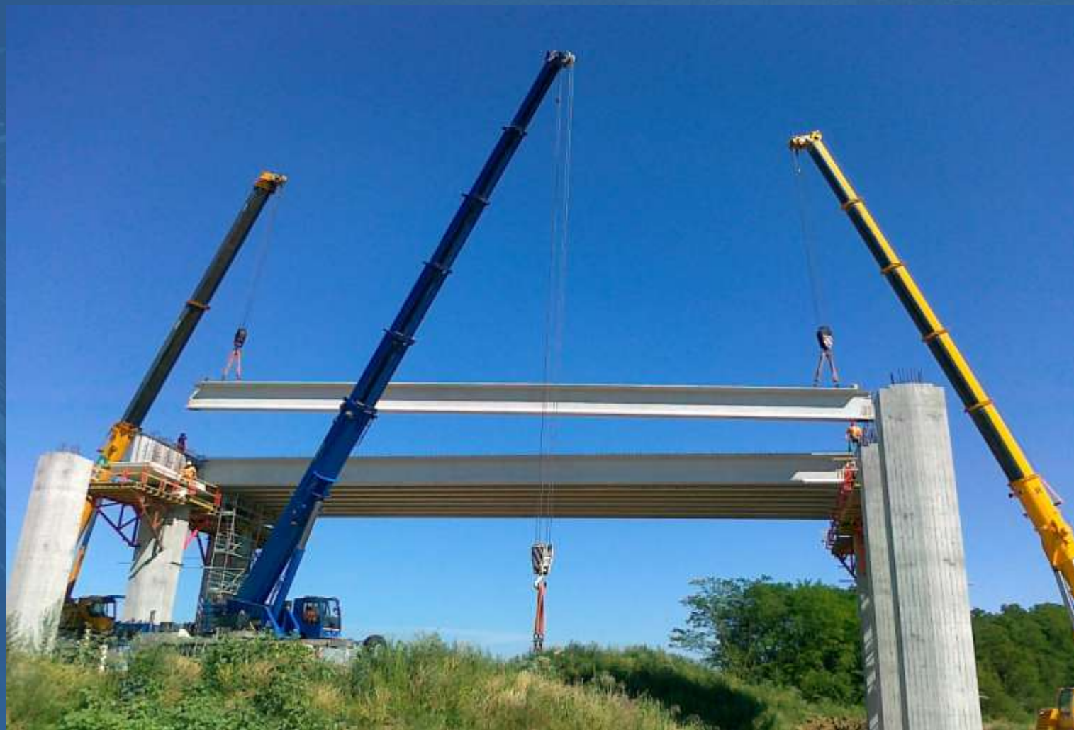
Obr. 7. Objekt 204– PPP R1 Selenec - Beladice
