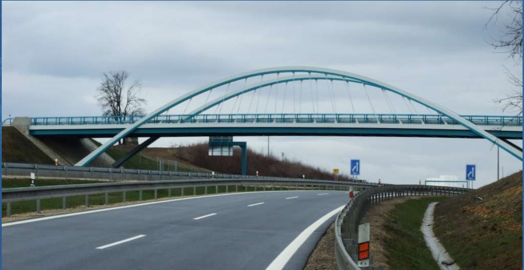
Obr. 3. Objekt 201 – most na R1 PPP I. úsek Nitra západ - Selenec
