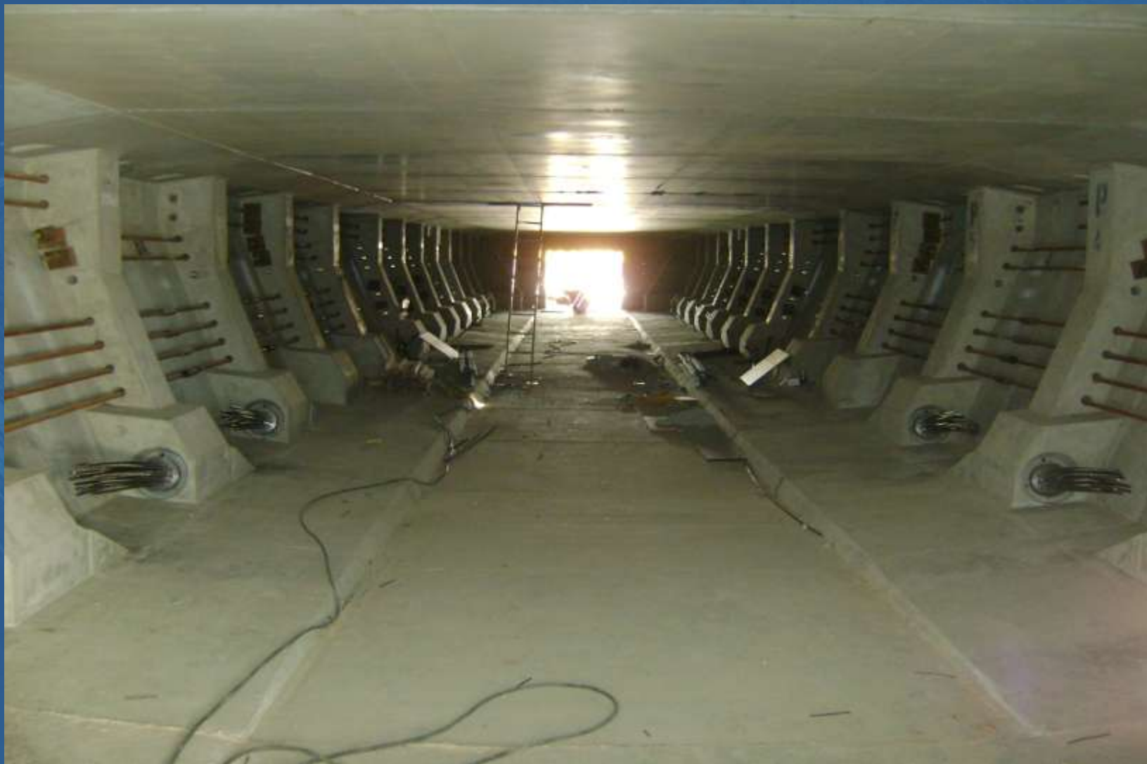
Obr. 10. Objekt 203 – most na R1PPP II. úsek Selenec - Beladice
