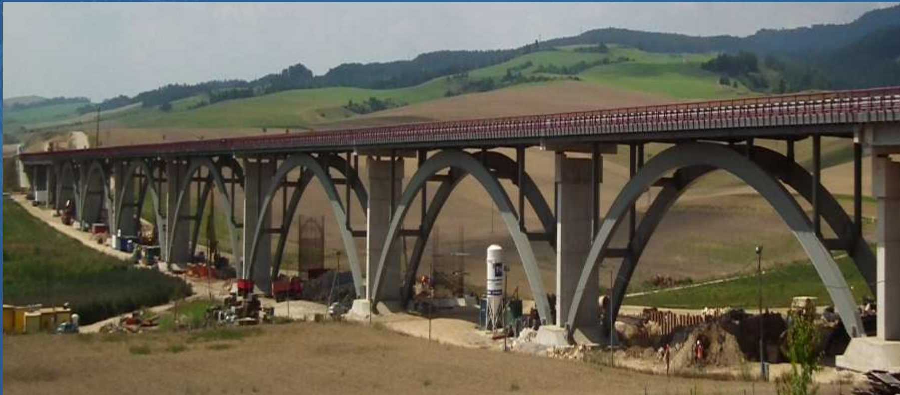
Obr. 2. Objekt 205 – pravý most na D1 Jablonov-Studenec, montáž ocelejovej oblúkovej konštrukcie
