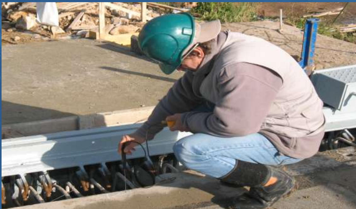
Obr. 16 meranie teploty pri osadzovaní mostného záveru
